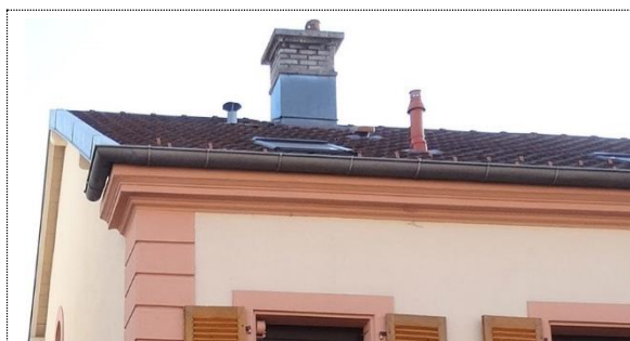
Exemple de corniche moulurée
