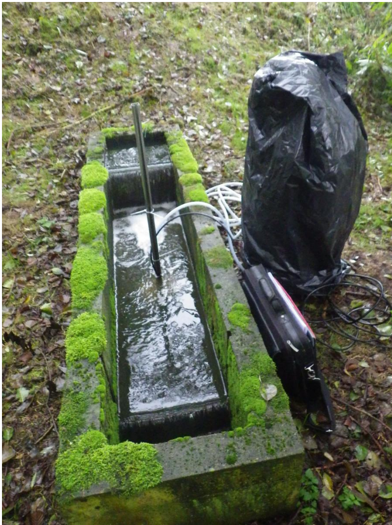
Figure 3 : Mesure de débit en sortie de station
