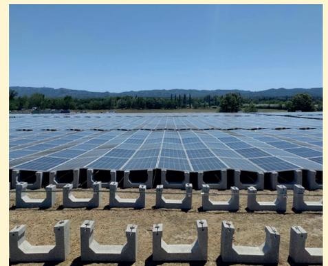
Ces blocs, fabriqués dans les Bouches-du-Rhône, seront directement posés sur le sol. Ils présentent ainsi l'avantage de pouvoir être installés rapidement sans impact sur le sol. En fin de vie de la centrale, ils seront facilement retirés puis recyclés.
