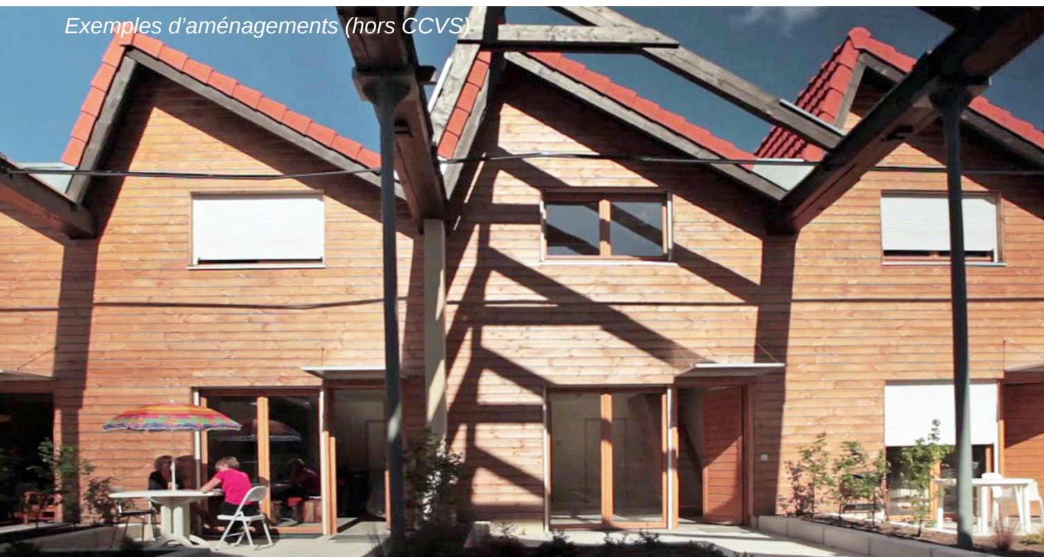
Requalification de la friche Fontanille au Puy-en-Velay (Axis architecture) / Ancienne ferme réhabilitée (DR)
