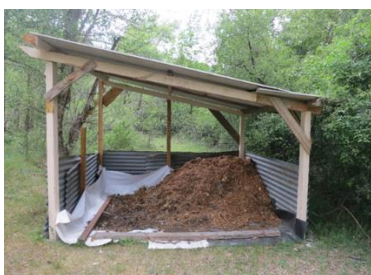
exemple de toilettes sèches conformes
