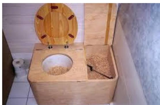
Pour l'urine, la sciure doit être mise avant car l'eau doit être absorbée en surface avant d'inonder le fond. Il est peu utile de rajouter la litière (sciures, copeaux...) après l'urine.
