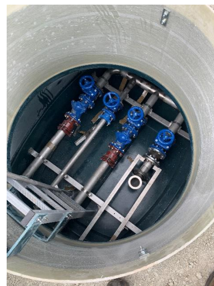
Chambre à vannes
