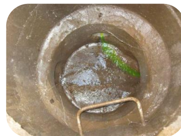
Validation de la connexion hydraulique à l'aide de colorant
