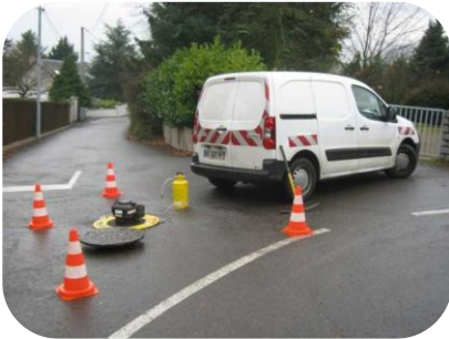
Injection de fumée dans le réseau d'eaux usées
