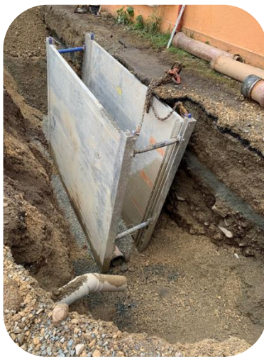
Travaux rue Traversière à Chaux
