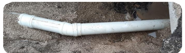
Remplacement d'un coude sur le réseau à Auxelles-Haut
