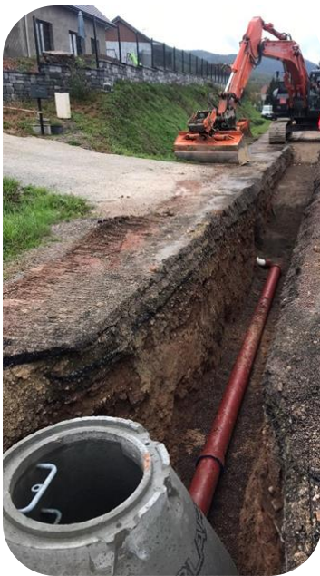
Travaux rue du Rosemont à Vescemont
