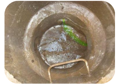
Validation de la connexion hydraulique à l'aide de colorant
