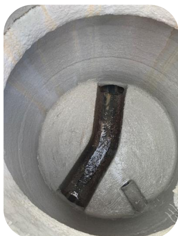
Regard réhabilité rue des Oiseaux à Chaux
